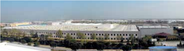
Kaynak Tüketim Malzemeleri Fabrikası Organize Sanayi Bölgesi 2. Kısım - MANİSA
